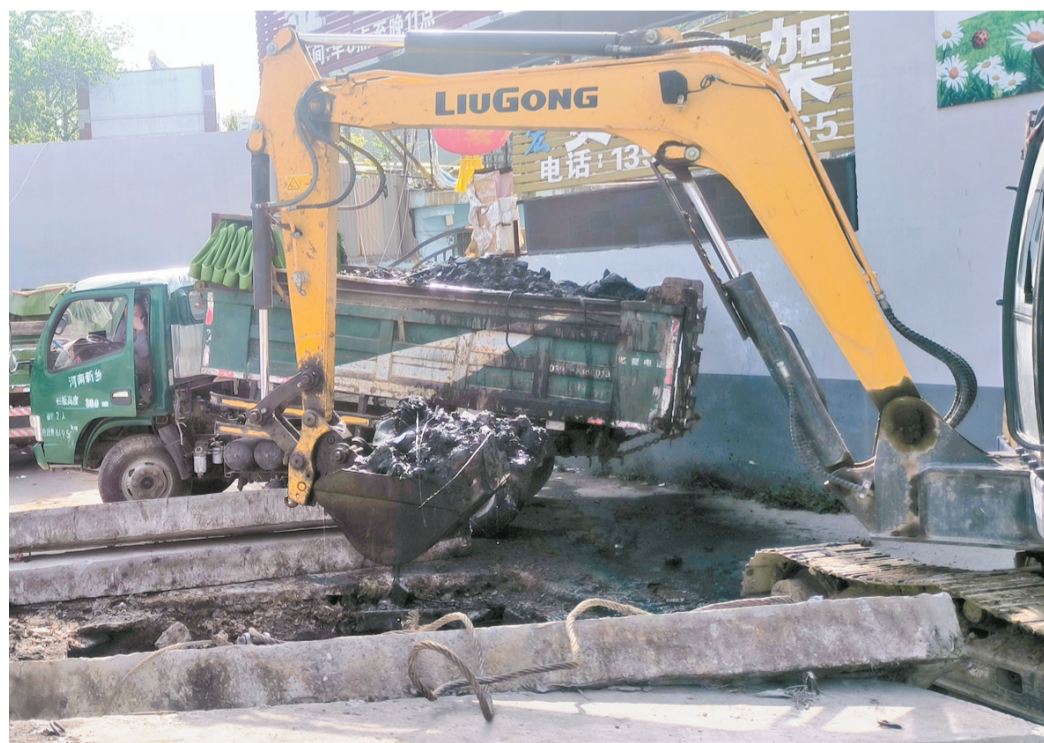
为提升城市排水防涝能力、保障汛期排水通畅,4月8日,卫滨区城管局启动全家营沟沟、西孟沟沟淤疏浚工作。该区组织20余人,出动垃圾清运车2辆、挖掘机1台,采取人工清挖与机械清挖相结合的方式,清出淤泥约80立方米。
