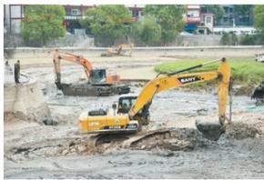
市水利局克服交叉施工、用电、环保、排淤场及堆土场协调等问题,早谋划、早部署、早落实,提前对主河槽进行勘测,严控开挖超深,保护现有河岸结构和过河建筑物安全。为抢抓汛前施工黄金期,采取“抢、战、移、运”四字工作法,投入人力500余人,组织200
