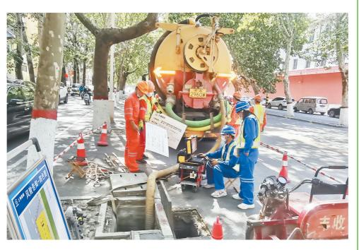
目前,市城管局坚持管网清淤与错混接、管网系统完善、管网功能修复同步的原则,加班加 点推进市区地下雨污水管网清淤疏通和修复改造工作,为安全度汛打下坚实基础。
