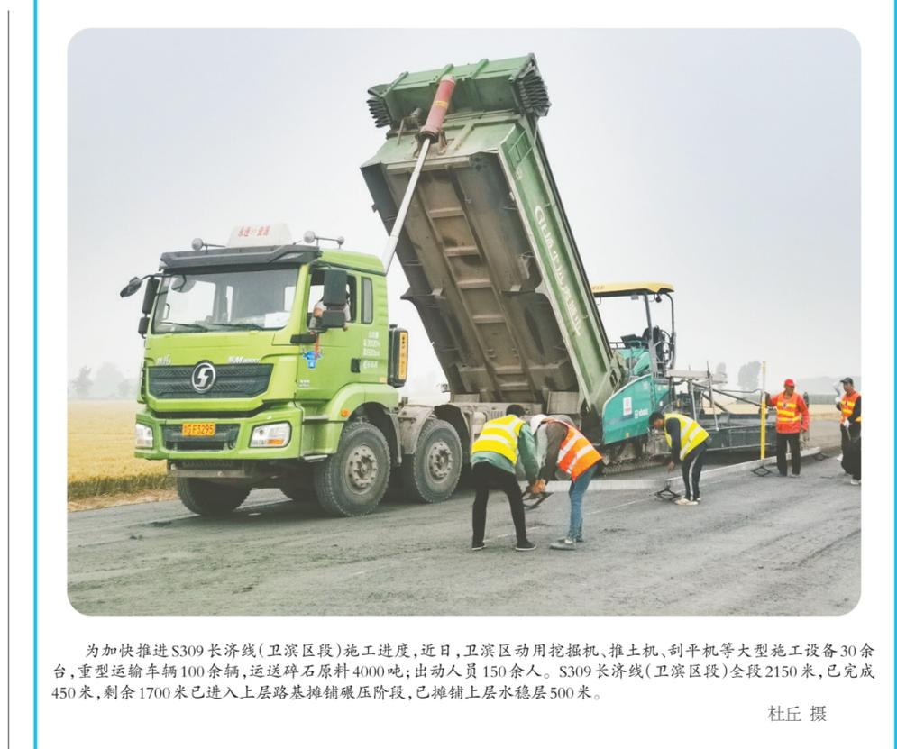
为加快推进S309长济线(卫滨区段)施工进度,近日,卫滨区动用挖掘机、推土机、刮平机等大型施工设备30余台,重型运输车辆100余辆,运送碎石原料4000吨;出动人员150余人。S309长济线(卫滨区段)全段2150米,已完成450米,剩余1700米已进入上层路基摊铺碾压阶段,已摊铺上层水稳层500米。
