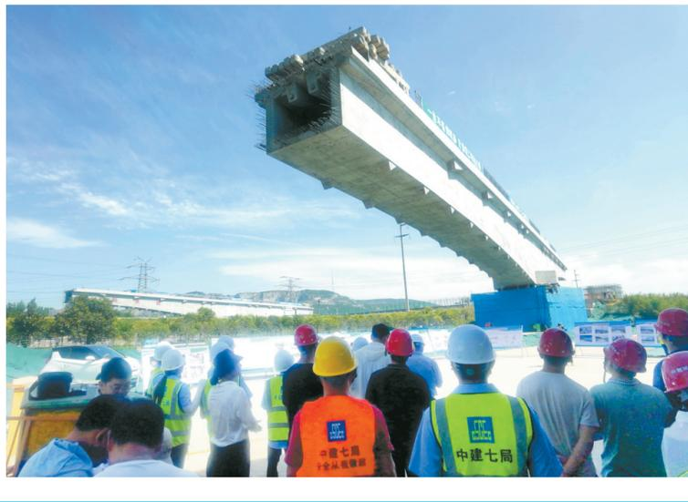
7月8日,中建七局交通公司新乡凤凰山引水工程项目跨南水北调管道桥顺利完成转体。该项目桥梁全长280米,单跨最大130米,桥宽6米,单幅设计,是河南区域南水北调沿线首座采用该技术的桥梁工程,对南水北调桥梁施工的技术创新具有重要意义。新乡日报全媒体记者李青春 摄
