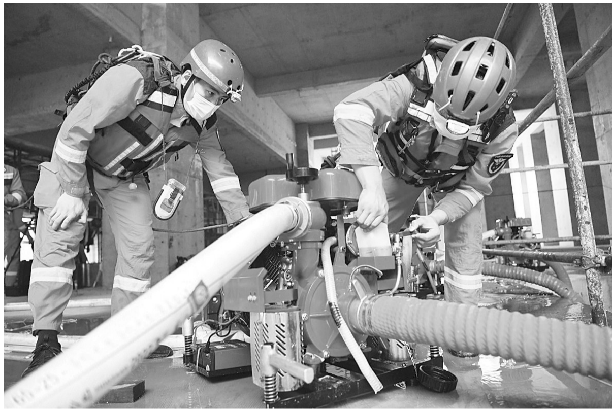
8月7日，邢台市消防救援支队队员在河北省涿州市一处工地进行排涝作业。连日来，河北省消防救援总队调集唐山、邯郸、衡水等地区7个支队、800多名消防救援人员投入到涿州市积水严重地区进行排涝作业。消防救援人员连续奋战，为涿州市受灾严重地区尽快恢复正常生产生活提供保障。 新华社记者 朱旭东 摄
