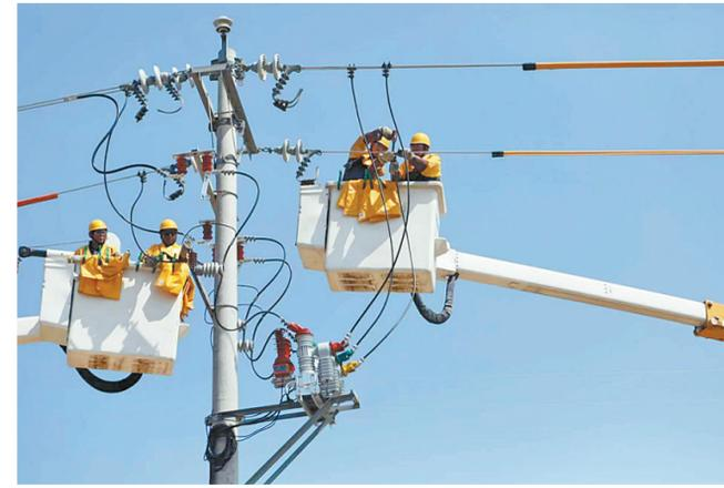
本报讯 日前,卫辉市供电公司联合新乡供电公司带电作业中心开展“联合”作战,对10千伏南线开展旁路作业更换柱上开关,保障用户放心用电。
