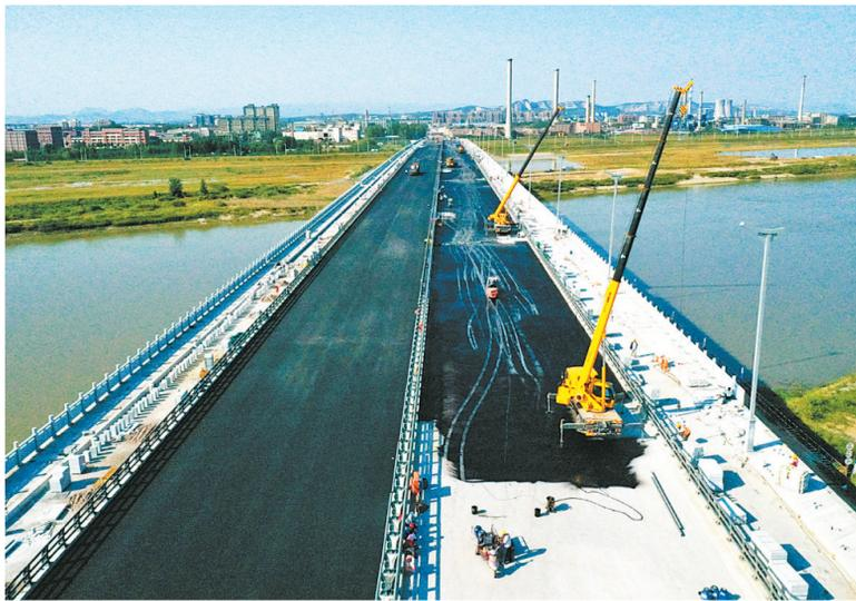
目前,牧野大道凤泉湖桥项目进入收尾阶段,预计国庆节前可实现通车。该项目是连接主城区和凤泉区的一条重要通道。桥梁长度1.057公里。桥面宽47米,设计为双向八车道,设计速度为每小时50公里。项目竣工后,对提升完善城市交通网络体系、推动区域经济发展等具有重要意义。图为路面正在铺设沥青。
