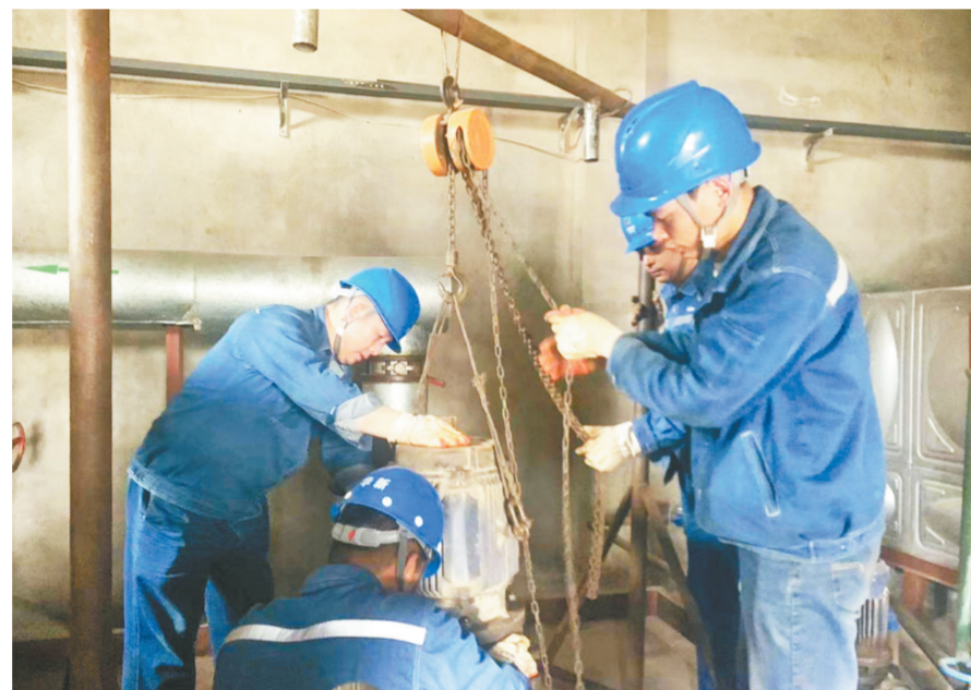
工作人员在进行水泵检修更换
