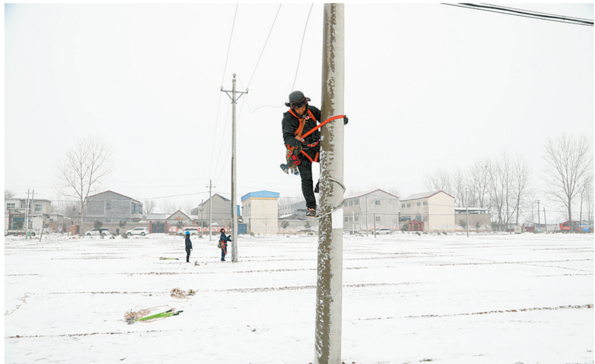
因近期雨雪冰冻恶劣天气影响,封丘县辖区内杆塔、导线等设备均出现严重覆冰现象,造成线路频繁跳闸、导线脱落等。封丘县供电公司迅速启动应急预案,全力保障雨雪过后安全平稳供电。图为封丘县供电公司组织抢修人员对10千伏前线路庄分支支线路覆冰和舞动导致线路断开开展抢修工作。 靳运东 摄
