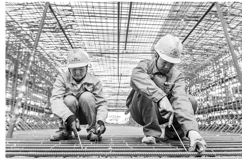
1月2日，在位于上海市浦东新区祝桥镇的沪苏通铁路二期中铁四局站前Ⅶ标项目施工现场，工作人员进行箱梁钢筋绑扎作业。新年伊始，各行各业的劳动者忙碌在各自的岗位上，接续奋斗，干劲十足。新华社记者 王翔摄
