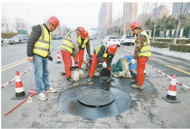
为解决低温天气下窨井盖维修养护周期长、影响交通等问题,近日,市城管局对“病害”窨井盖进行了整治维修,守护好人民群众“脚下的安全”。图为工作人员正在中东路整修窨井盖。 新乡日报全媒体记者 赵云 通讯员 李亚超 摄
