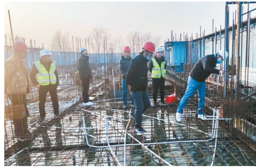
在建筑工地进行安全生产检查
