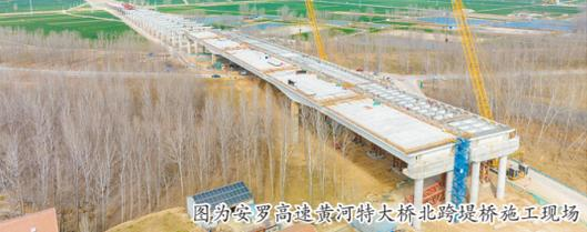
本报讯(新乡日报全媒体记者 翟克元 通讯员 黄雪坤 靳文/图)3月17日,安罗高速黄河特大桥北跨堤桥顺利合龙,钢结构部分全部施工完成。
