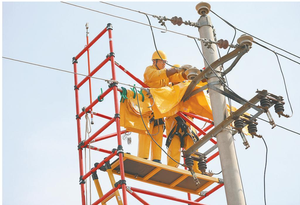
**本报讯** 日前,在封丘县荆隆宫乡小齐寨村,封丘县供电公司采用绝缘平台开展带电作业的方式,在不影响周边村民正常用电的情况下,顺利完成带电作业抢修连接引线工作。
