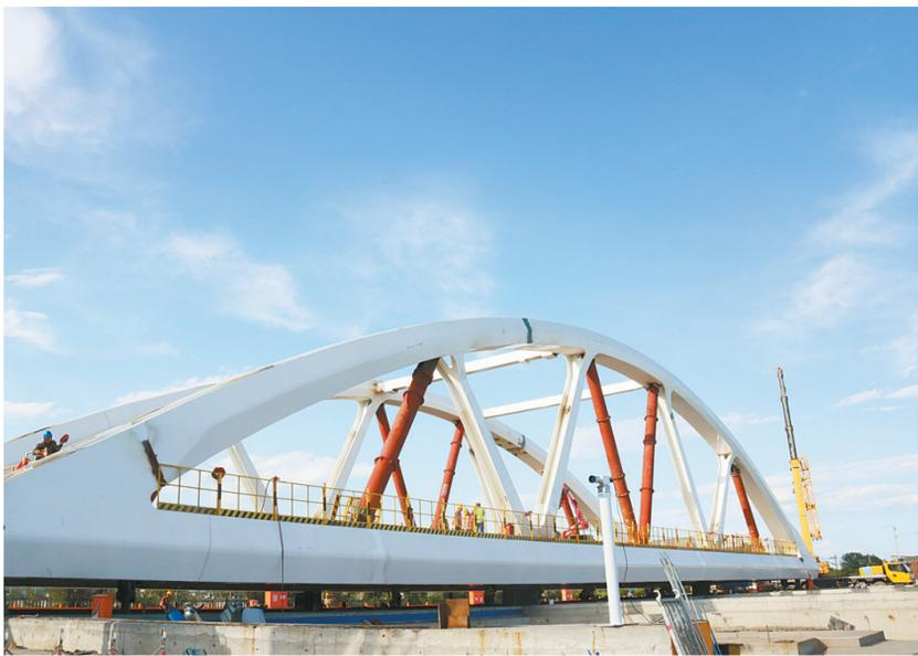
6月3日,工人在进行焊接工作。当日,京唐城际铁路北京副中心段控制性工程——跨通济路桁架型钢箱简支拱桥顶推完成,为线路全线贯通奠定坚实基础。新华社发 国铁北京局供图
