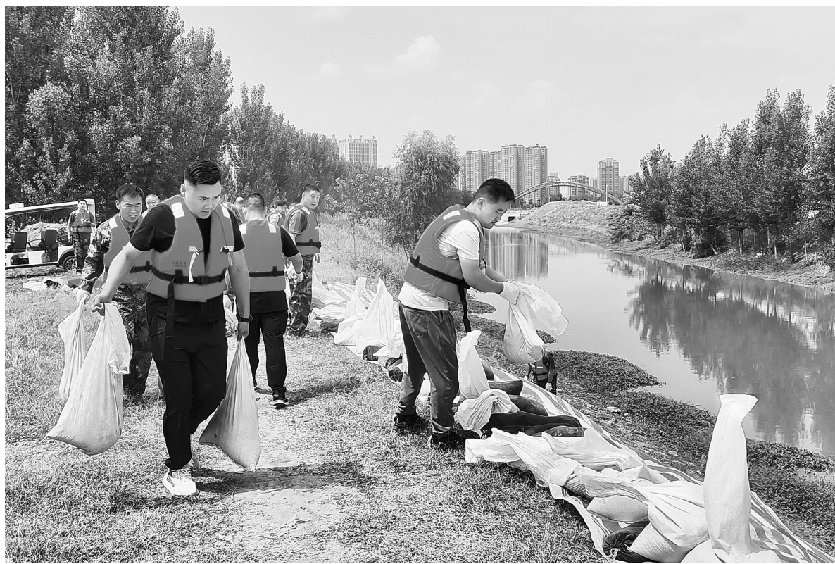
6月28日，红旗区开展“应急使命-2024红旗区防汛综合应急演练”，旨在增强居安思危、防患未然的危机意识，提高应对突发事件的能力。
