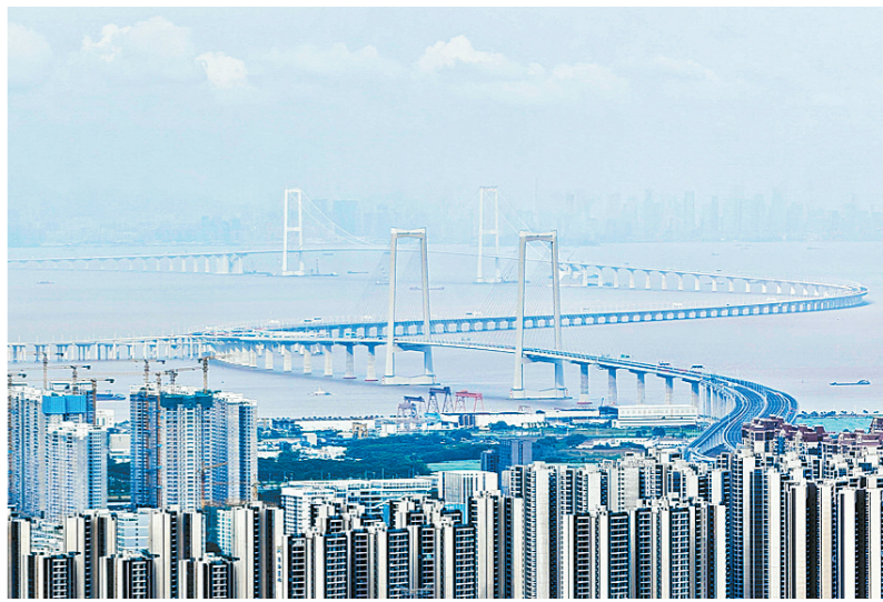
6月30日,历时七年建设的国家重大工程深中通道正式通车试运营,从深圳到中山的车程从原来的2小时缩短至30分钟。深中通道全长约24公里,集“桥、岛、隧、水下互通”于一体,是世界上综合建设难度最高的跨海集群工程之一。
