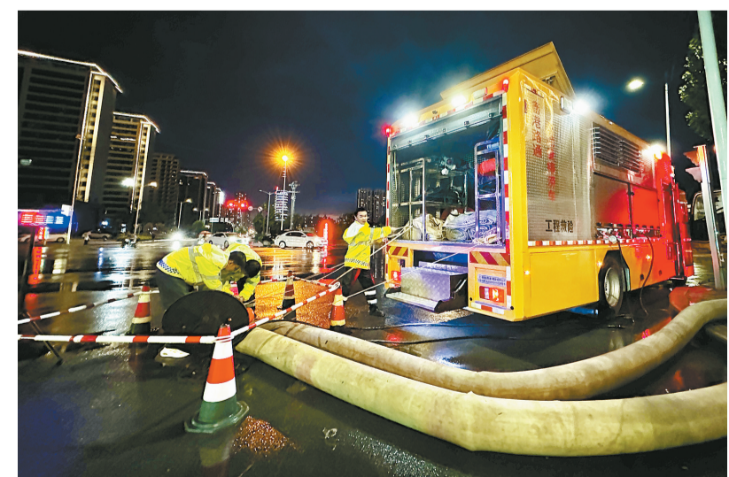
7月22日晚,我市突遇暴雨袭击,城管部门迅速响应,全面启动应急预案,市区44座泵站全员提前上岗,路段巡视及平台监控人员加强低洼路段、立交涵桥等积水巡查,28台移动泵车分布在市区多个点位全力进行移动抽排,路段排水人员及时开井设置警示,全力保障城市安全和市民生活秩序。
