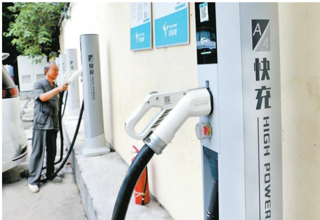
随着新能源汽车市场迅猛发展,充电桩作为重要的新型基础设施,我市加速布局,大功率(快充)充电桩数量不断增长,满足更多新能源汽车用户需求。图为车主正在使用充电桩充电。
