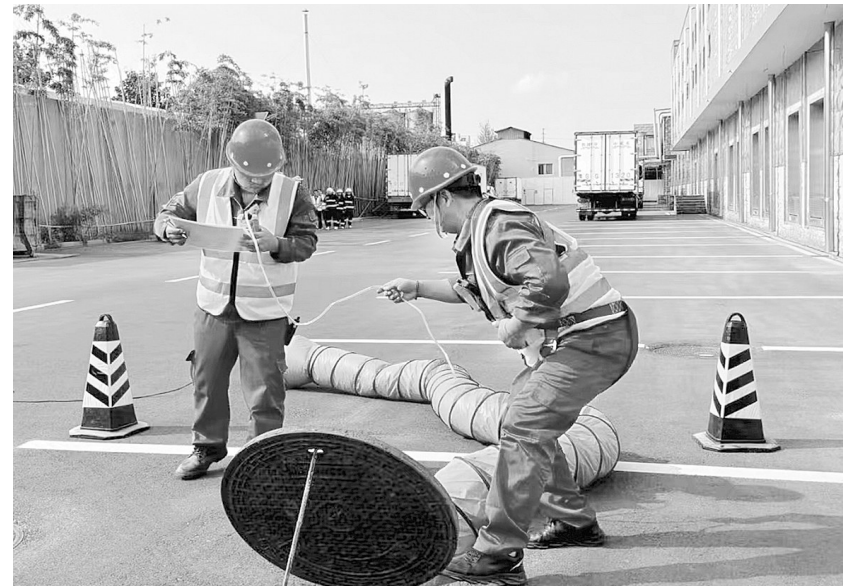
为进一步提升应对有限空间作业事故处置能力，近日，原阳县应急管理局开展有限空间作业安全警示教育，该县70余家涉及有限空间的企业负责人和安全管理人员参加活动。
