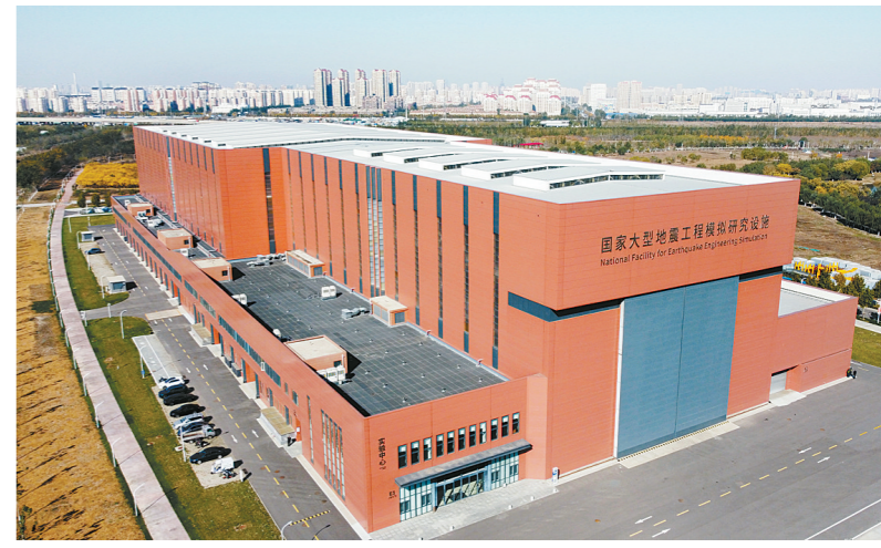
这是11月5日拍摄的位于天津大学北洋园校区的国家重大科技基础设施“大型地震工程模拟研究设施”。当日,国家重大科技基础设施“大型地震工程模拟研究设施”项目在天津大学通过国家验收并正式投入运行。
