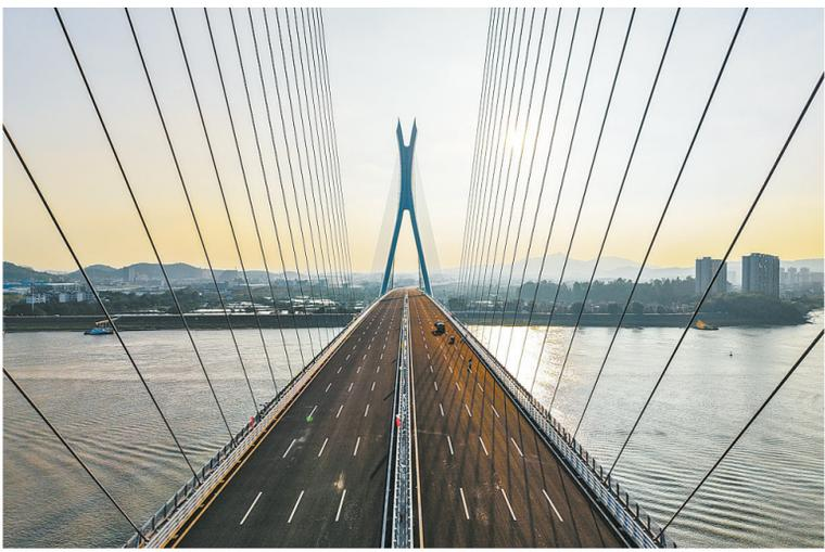
由中交路桥承建的富龙西江特大桥将于十一月二十二日通车。富龙西江特大桥起佛山高明区，东至佛山三水，主桥为双塔双索面组合斜拉桥。通车后，将进一步改善广佛西部片区综合交通体系，推进西江两岸城市联通发展。
