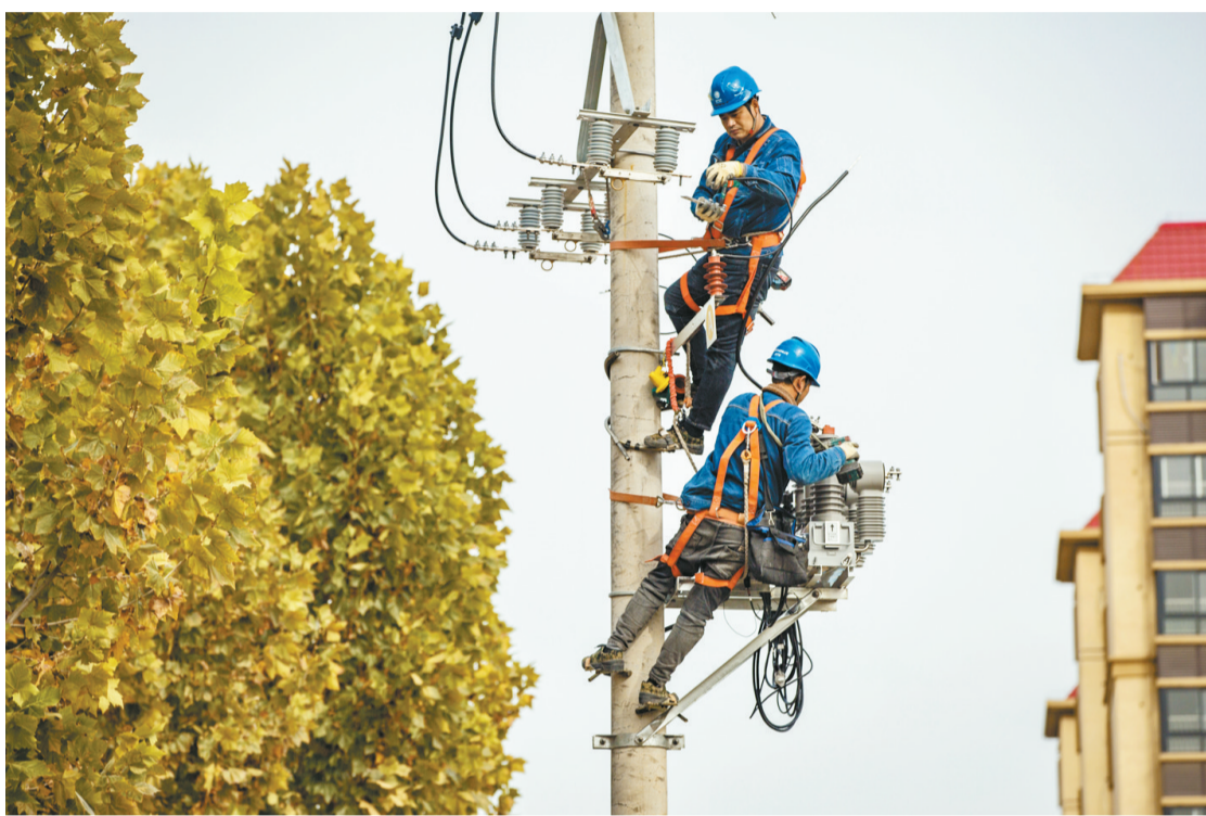
图为国网新乡供电公司工作人员对中原农谷配电网线路加装智能开关,提高供电的灵活性和可靠性。新乡日报全媒体记者 赵云 摄
