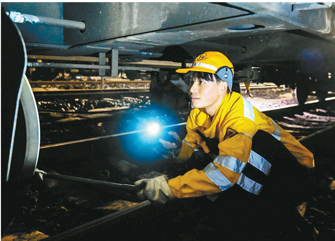
2月19日,在柳州南编组站,检车员在检查车轮。春运接近尾声,中国铁路南宁局集团有限公司多部门联动积极开展巡查,检修设备,及时消除安全隐患,站好春运末班岗。
