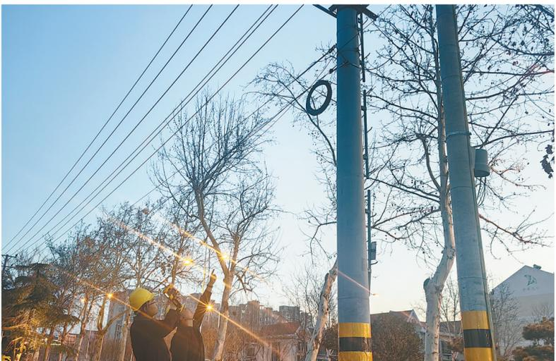
本报讯“测温正常,设备运行正常,未发生接点发热等异常情况。”日前,新乡供电公司城南供电部组织工作人员对辖区内的城镇用电高峰小区、配电线路、变压器进行夜巡及红外测温工作,全面检查高负荷时段线路设备运行状态,做到有问题早发现、有隐患早排查、有缺陷早处理,坚决扛牢电力保供的重要责任(如图)。
