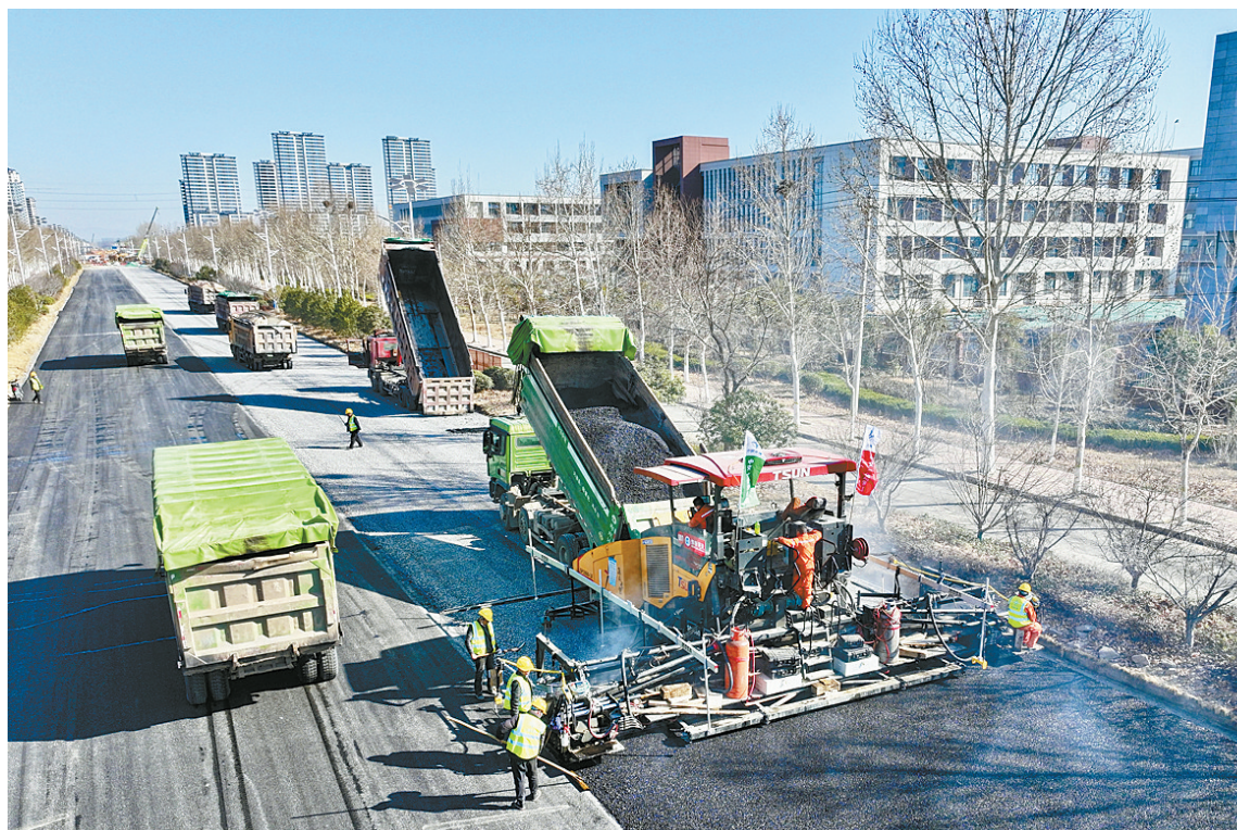
日前,在郑新快速路施工现场,工人们正加紧作业,确保工程如期竣工。新乡日报全媒体记者 赵云 摄
