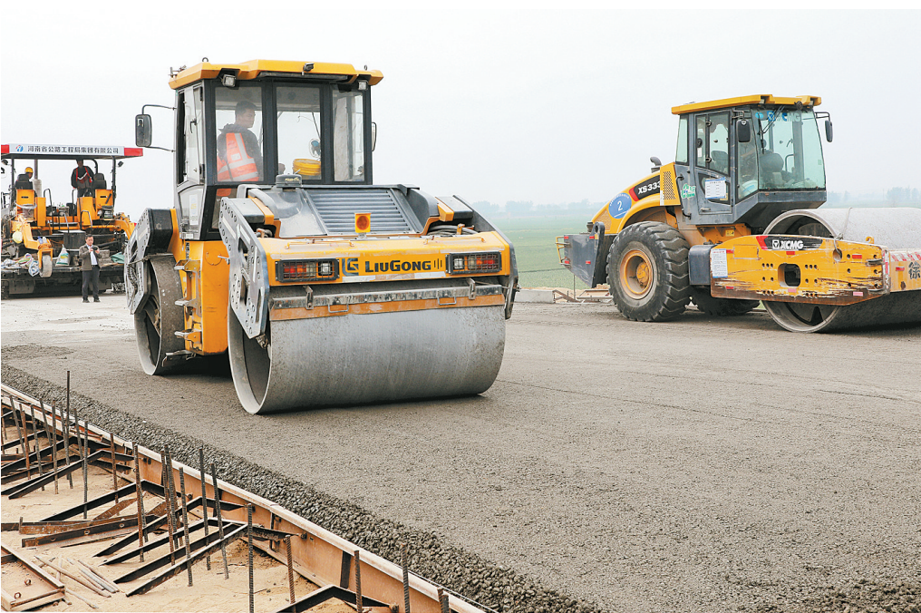
日前，长修高速封丘至修武段项目施工现场热火朝天。李青春 摄
