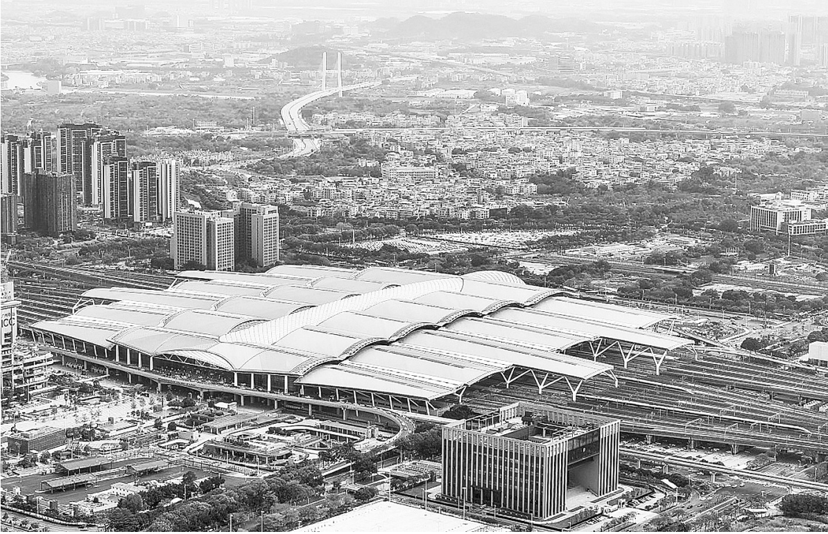
这是4月28日拍摄的广州南站(无人机照片)。广南联络线将从广州南站导出，一站直达位于中心城区的广州站。当日，由中铁十一局承建的广(广州站)南(广州南站)联络线建设开启加速度，“永庆号”大直径盾构机始发，跨动走线特大桥开始现浇梁施工。 广南联络线建成后，京广高铁、广深港高铁、贵广高铁、南广高铁等铁路线可直达位于中心城区的广州火车站，广州大都会交通枢纽功能将进一步增强。
