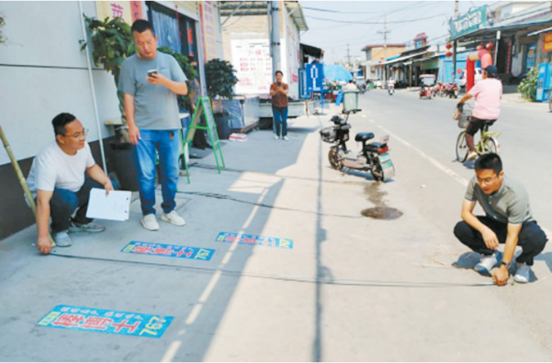
图为审计人员深入项目现场实地丈量的情景
