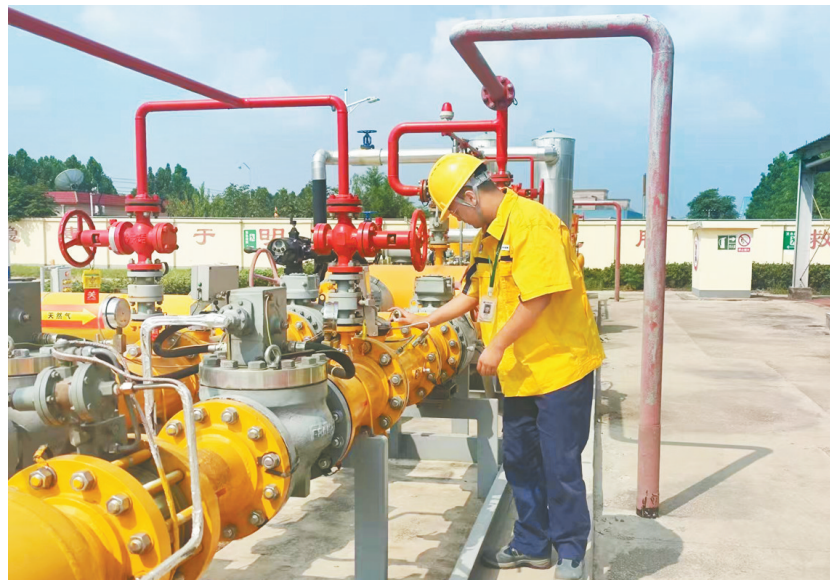
图为员工检查燃气调压站管道和阀门
