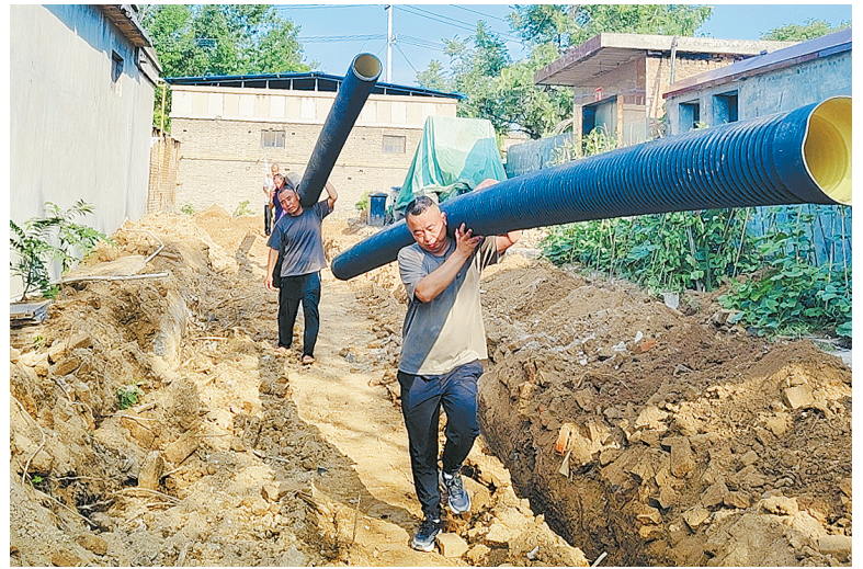
近日,卫辉市后河镇关帝庙村“三通一规范”工程正在实施。该村推行“村干部带头、村民义务参与”模式,不仅节省工程成本,项目推进速度也显著提高。图为村干部带领群众修建污水管网。 新乡日报全媒体记者 赵云 摄
