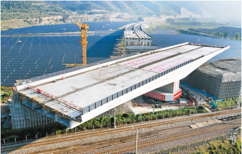
这是8月11日拍摄的河南省济源市沿太行山高速公路跨焦柳铁路立交桥转体施工现场(无人机照片)。当日,由中铁大桥局承建的河南省济源市沿太行山高速公路上跨焦(作)柳(州)铁路立交桥成功转体。转体主梁总长130米,总重量达2.1万吨。
