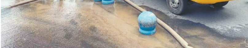
图为抢修现场
