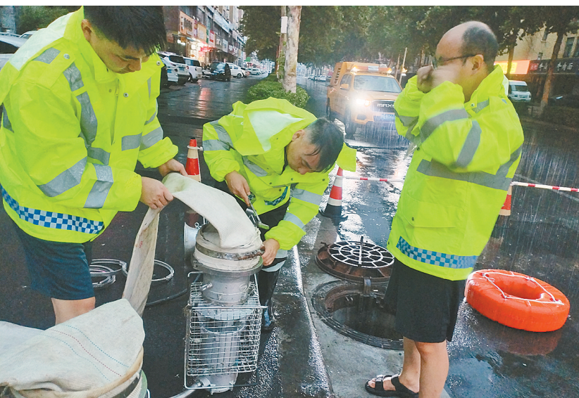
图为在荣校东路理想城附近,市城管防汛抢险队员正在架设移动抽排水泵
