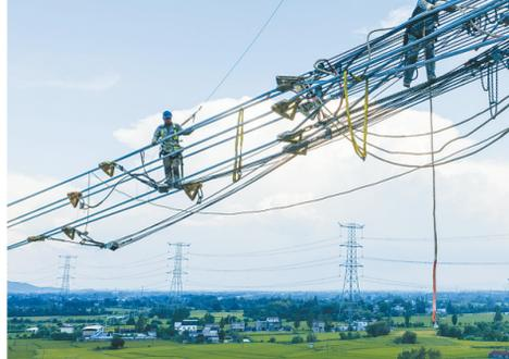
在安徽省芜湖市南陵县,安徽送变电工程有限公司施工人员在高空进行架线施工。近日,甘肃至浙江±800千伏特高压直流输电工程安徽段进入架线施工阶段。甘肃特高压工程是国家“十四五”电力发展规划重点项目,起于甘肃省武威市,止于浙江省绍兴市。新华社记者 刘军喜 摄
