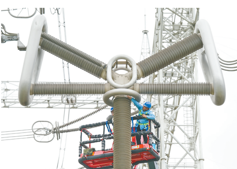
10月20日，安徽送变电工程有限公司检修人员在古泉换流站进行检修作业。10月17日至10月23日，准东—皖南±1100千伏特高压直流输电工程的受端站——安徽宣城古泉换流站迎来年度停电检修。国网安徽电力的900余名电力检修人员对古泉换流站进行集中检修，总计开展检修任务4525项，为长三角地区今冬明春可靠用电提供保障。准东—皖南±1100千伏特高压直流输电工程起于新疆昌吉换流站，止于安徽古泉换流站，是目前世界上电压等级最高、输送距离最远、输送容量最大的输电工程。
