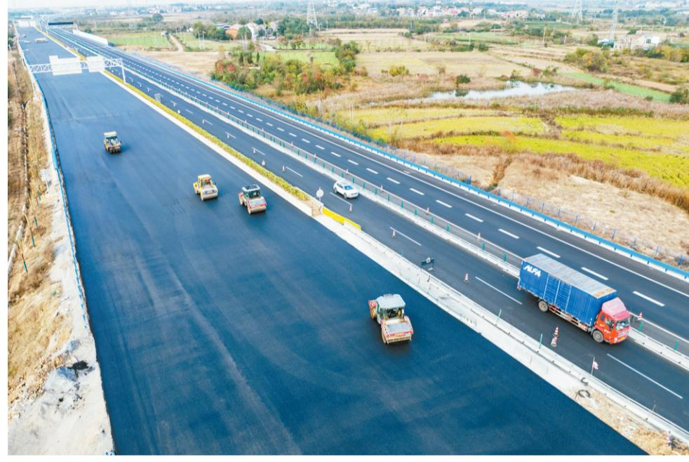
十一月二十日，中铁十一局工人在京港澳高速湖北北段改扩建工程中负责施工的京港澳高速枢纽互通匝道铺沥青。十一月二十日，由中铁十一局集团负责施工的京港澳高速枢纽互通匝道完成施工，正式建成通车，标志着京港澳高速湖北北段改扩建工程进入冲刺阶段。新华社记者 杜子璇 摄
