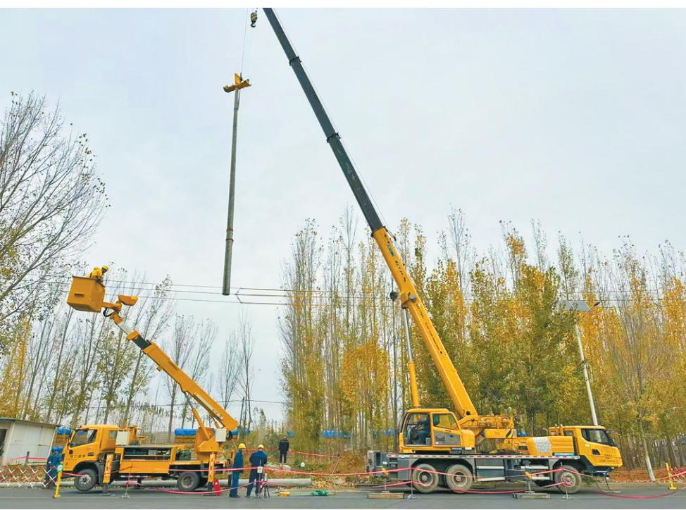
本报讯 11月17日,新乡供电公司带电工作人员在10千伏牛线区段顺利完成2基直线砼杆带电组立作业(如图)。本次施工全程实现“零停电”,有力保障了沿线千余户居民及企业的正常用电,以专业作业筑牢电网安全防线。
