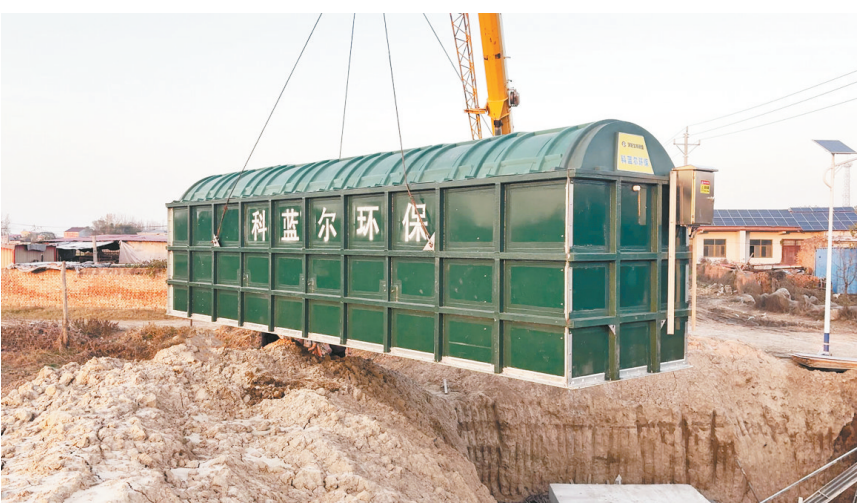
图为科蓝尔环保的产品正在吊装中
