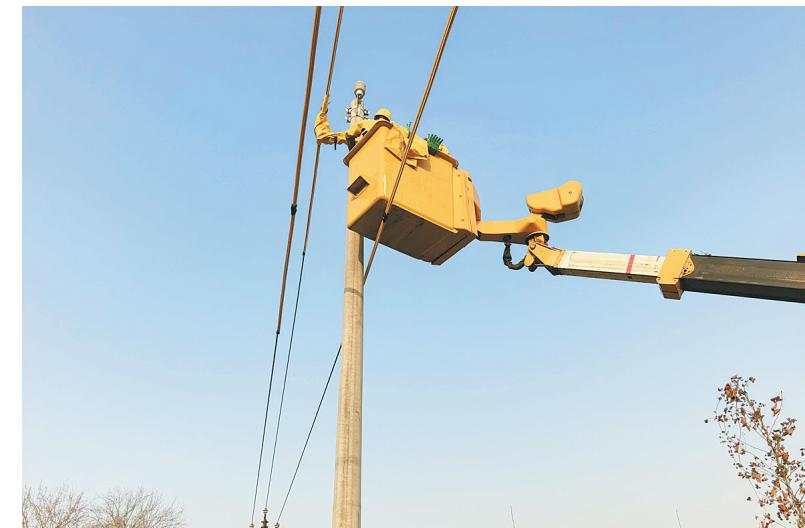
再次,新直线砼杆经平稳起吊、精准落入预置杆坑,快速完成基础加固与接地装置安装;最后,作业人员规范完成新杆与原有线路的搭接,全程关键步骤由班长现场复核确认。
