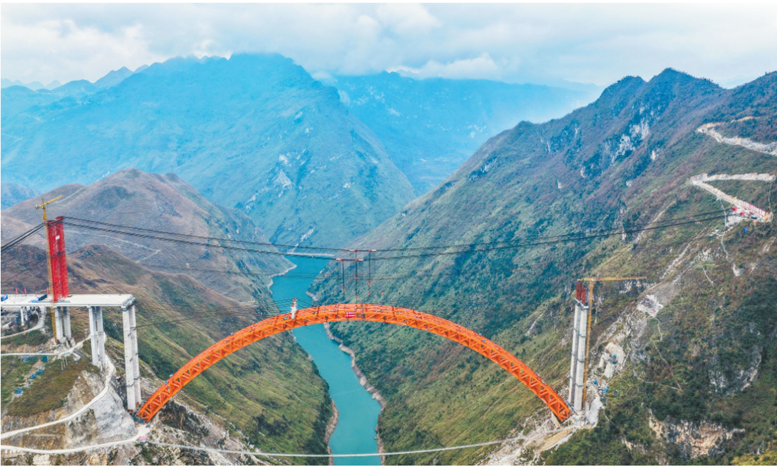
1月5日拍摄的安盘高速古牛河特大桥合龙现场(无人机照片)。1月5日,随着最后一节钢拱精准吊装到位,贵州交投集团承建的安顺至盘州高速公路古牛河特大桥顺利合龙,为后续工程建设推进奠定了坚实基础。古牛河特大桥是安盘高速控制性工程,全长881.8米,主桥横跨古牛河,主桥桥面到谷底高度约400米。
