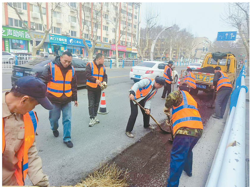
工作人员对破损路面进行整修
