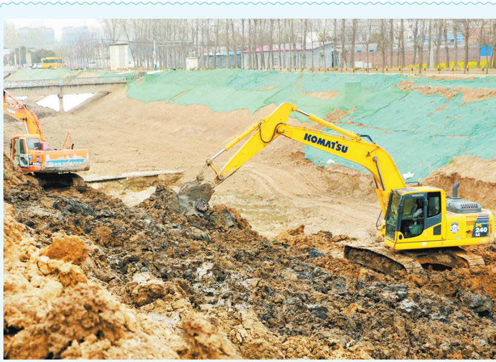
为筑牢汛期安全防线,近日,我市对人民胜利渠(黄河大道段)开展清淤、护坡及护底施工,确保渠道保持良好行洪状态,以万全准备迎战汛期,守护一方安宁。图为3月25日的施工现场。李青春 摄
