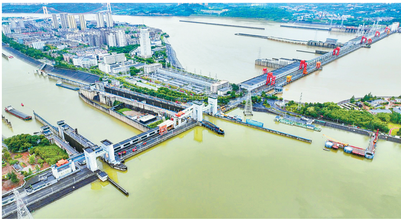
6月8日拍摄的三峡水运新通道工程葛洲坝航运扩能施工现场。
