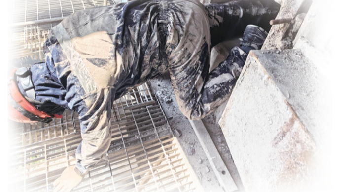
天瑞电站锅炉内部检验
