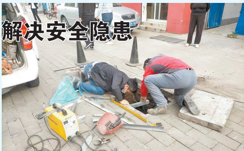
维修人员修复窨井盖
