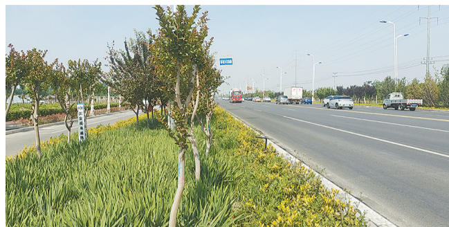
提升改造后的北环路
