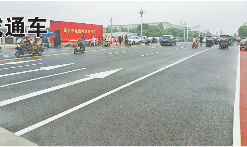
新建设桥通车
