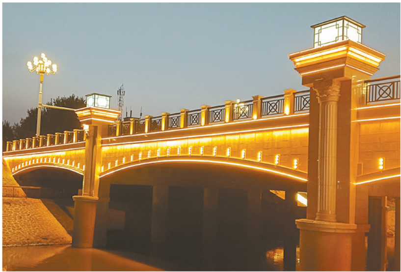
新建设桥夜景
